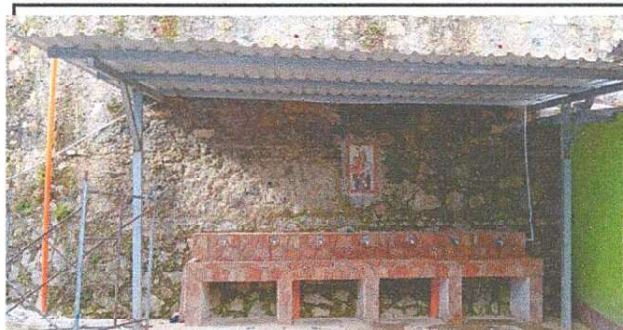
Foto 6: Entchado de proyecto lavano exterior, tubo de color anaranjado caída de agua pluvial.
